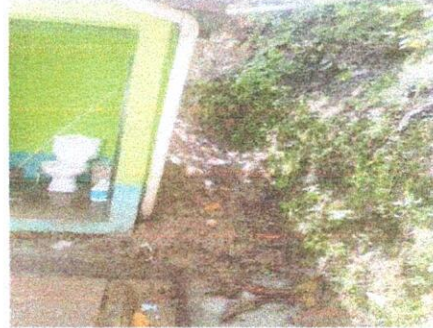
Foto8: Sustitución de sanitario de losa
