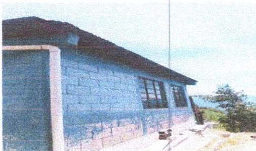
Foto 5: Sustitucion de lamina troquelada aluzinc calibre 24
