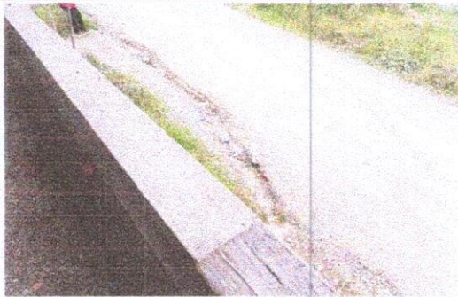
Foto1: Reparacion de muro perimetral de block
