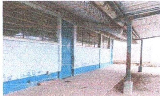
Foto 4: pintura interior y exterior
