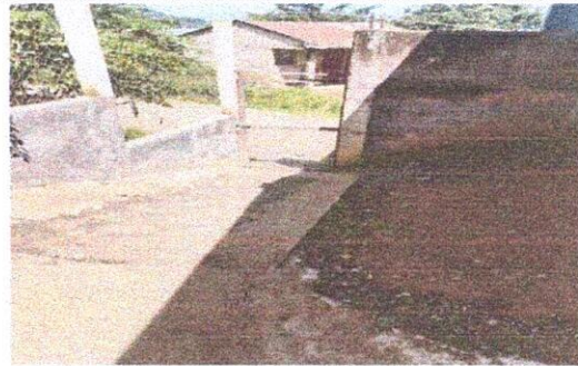
Foto 2: Sustitucion de puerta de malla por porton de metal
