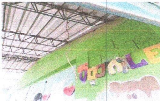
Foto 3: Reparacion del sistema electrico
